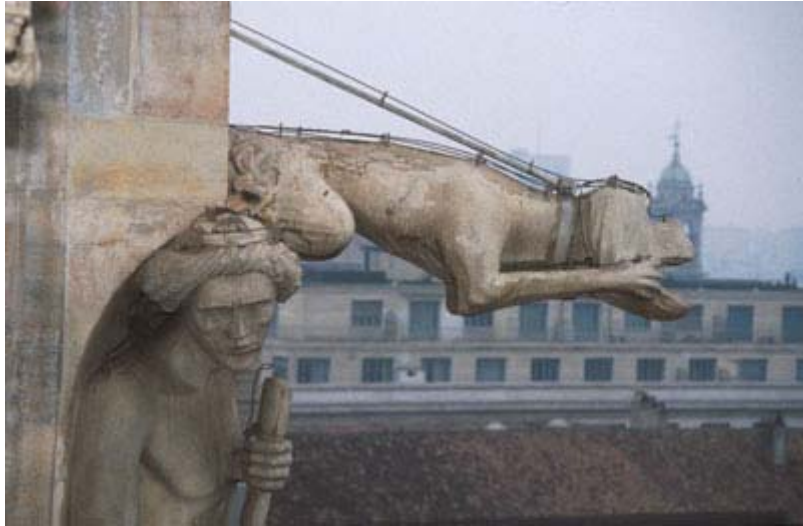
밀라노 돔에 설치되어 있는 것과 같은 전기 쇼크 시스템들은 단지 허용된 나라에서 반드시 낮은 전류로 이용되어야만 한다. Picture by Daniel Haag-Wackernagel
